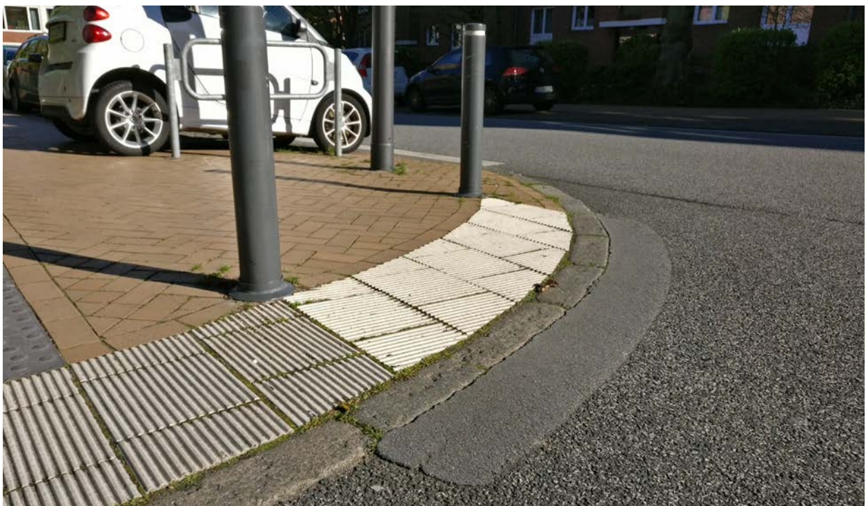
Abbildung 8: „Kieler Lösung“ für das nachträgliche Herstellen einer differenzierten Bordhöhe
